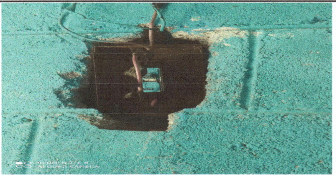
Foto 5: Cambio de cableado electrico, caja de flipones
