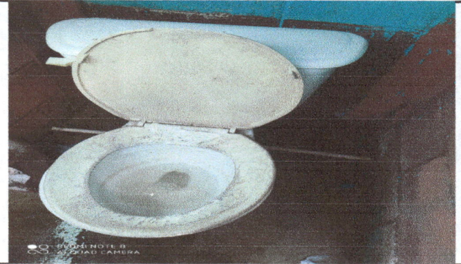
Foto 2: cambio de accesorios de sanitarios
