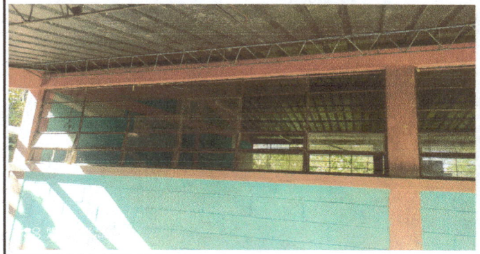
Foto 4: Colocacion de balcones
